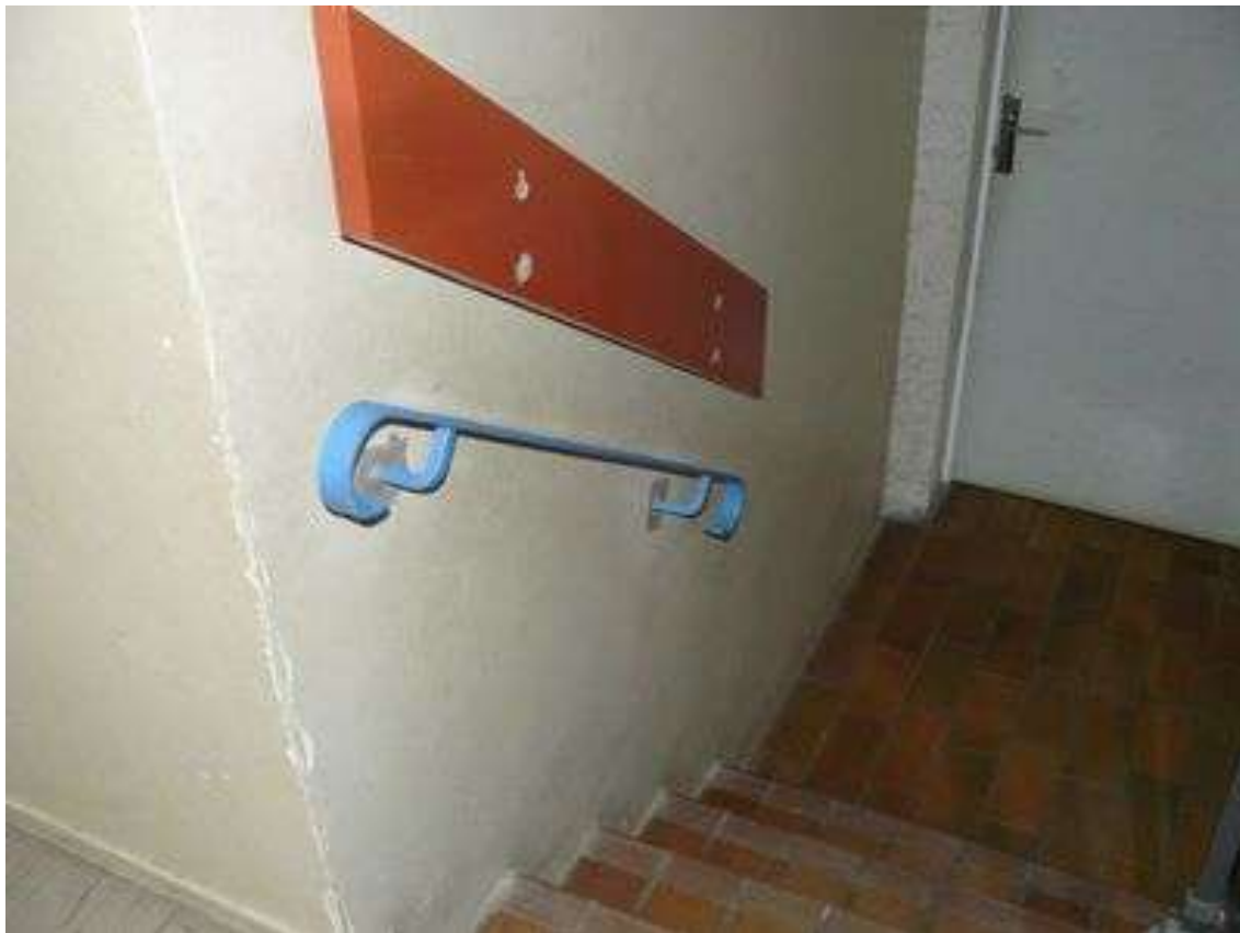
Pose d'une rampe d'accès à la bibliothèque
