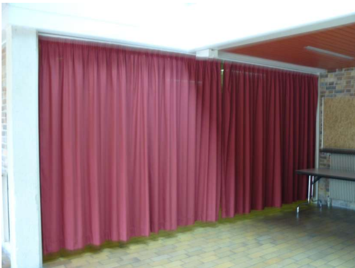
Pose d'une séparation (rideau) entre le bar et la salle
