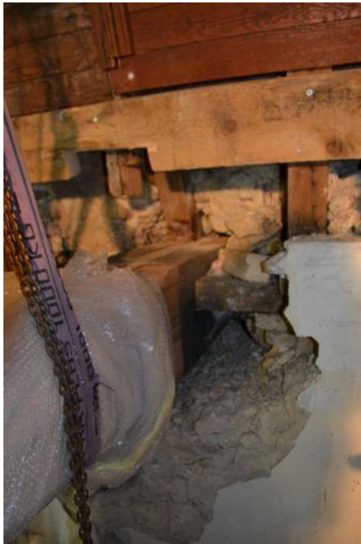
Morceau de poutre reposant sur le mur et recouvert d'une couche de papier goudronné pour l'isoler du scellement
