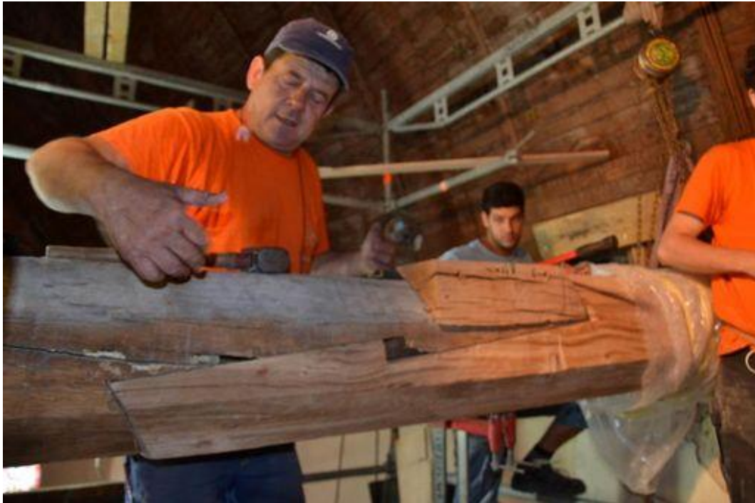
Explications du chef menuisier sur le raccordement des deux poutres et le principe de consolidation
