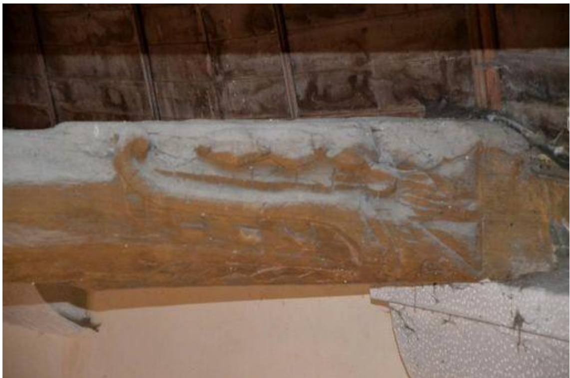
Le dragon de la poutre d'à côté
